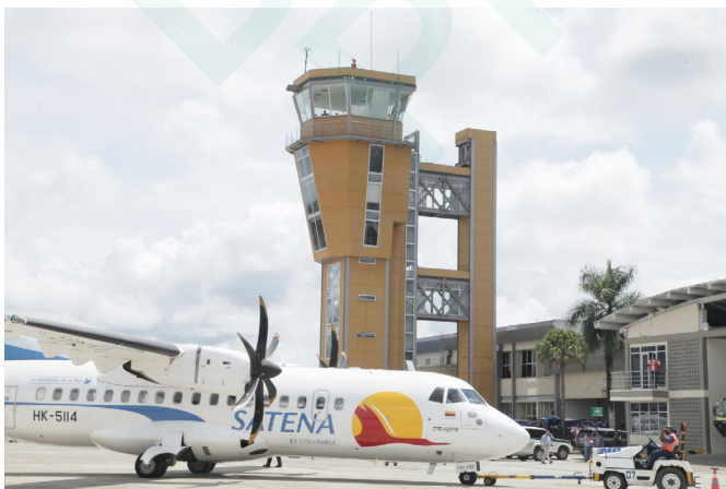
Fuente: Galería de imágenes del Ministerio de Transporte
